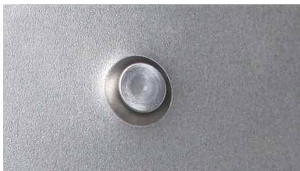
РЕЗУЛЬТАТ УСТАНОВКИ САМОПРОНИКАЮЩЕЙ ЗАКЛЕПКИ
