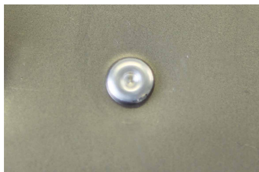
RISULTATO DELLA POSA DI UN RIVETTO FLOW- FORM
