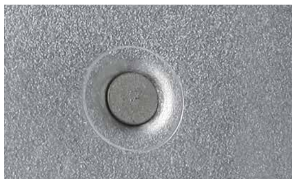
РЕЗУЛЬТАТ УСТАНОВКИ САМОПРОНИКАЮЩЕЙ ЗАКЛЕПКИ
